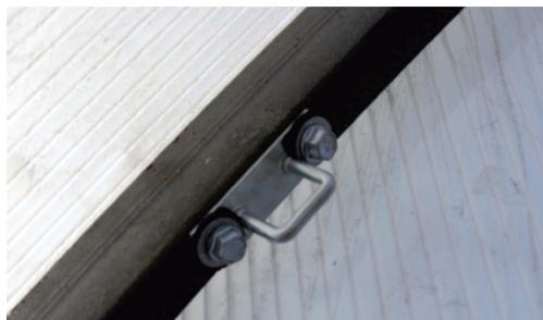
21. Дополнительно закрепить на дугах скобы внутри теплицы если они входят в комплект, чтобы можно было протянуть проволоку и подвязывать растения.
